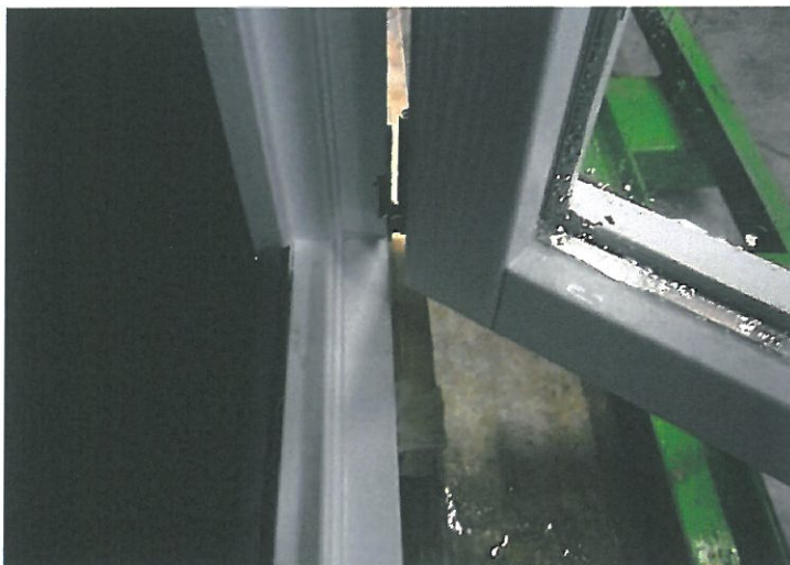
Détail liaison ouvrant / dormant
